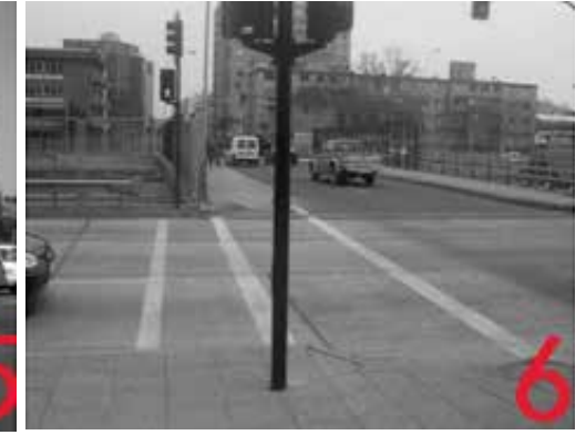
Puente Compañía, sobre Autopista Central
